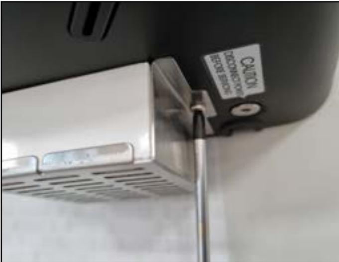
3. Monter et serrer complètement les vis de sécurité des deux côtés.
